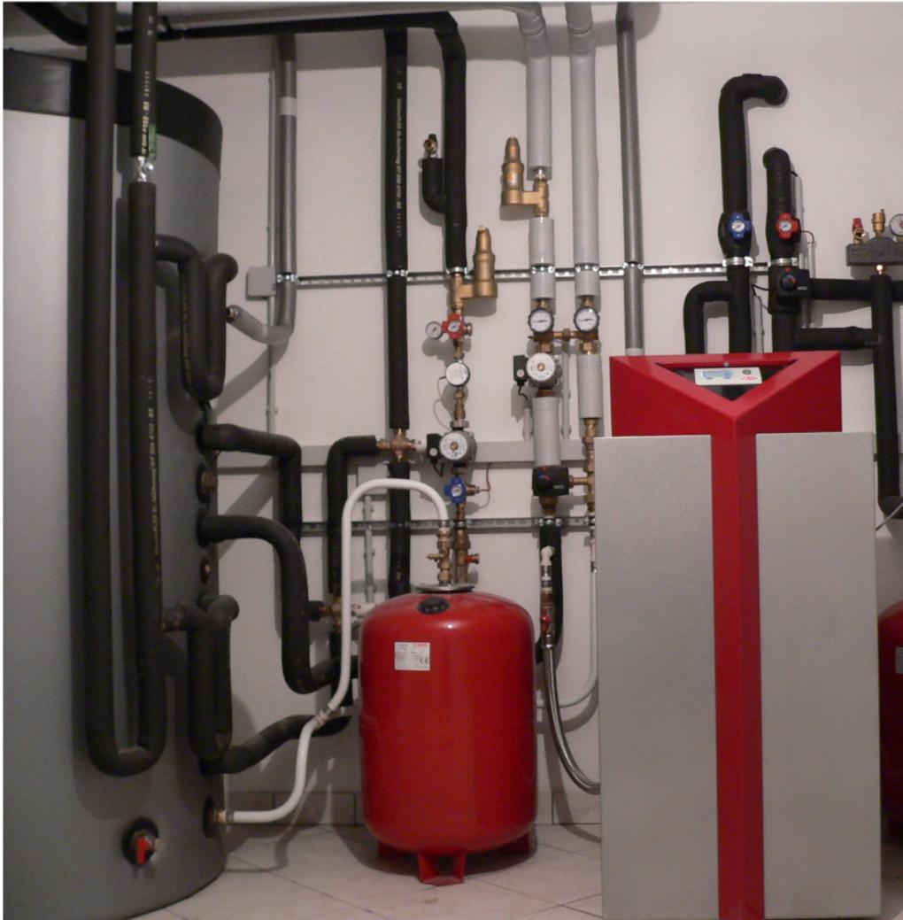
Bild 3 – Teilansicht der Solarheizungsanlage mit Pufferspeicher und Wärmepumpe von Thermosolar
